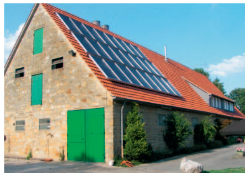
Landwirtschaftlicher Betrieb mit Aufdachmontage
