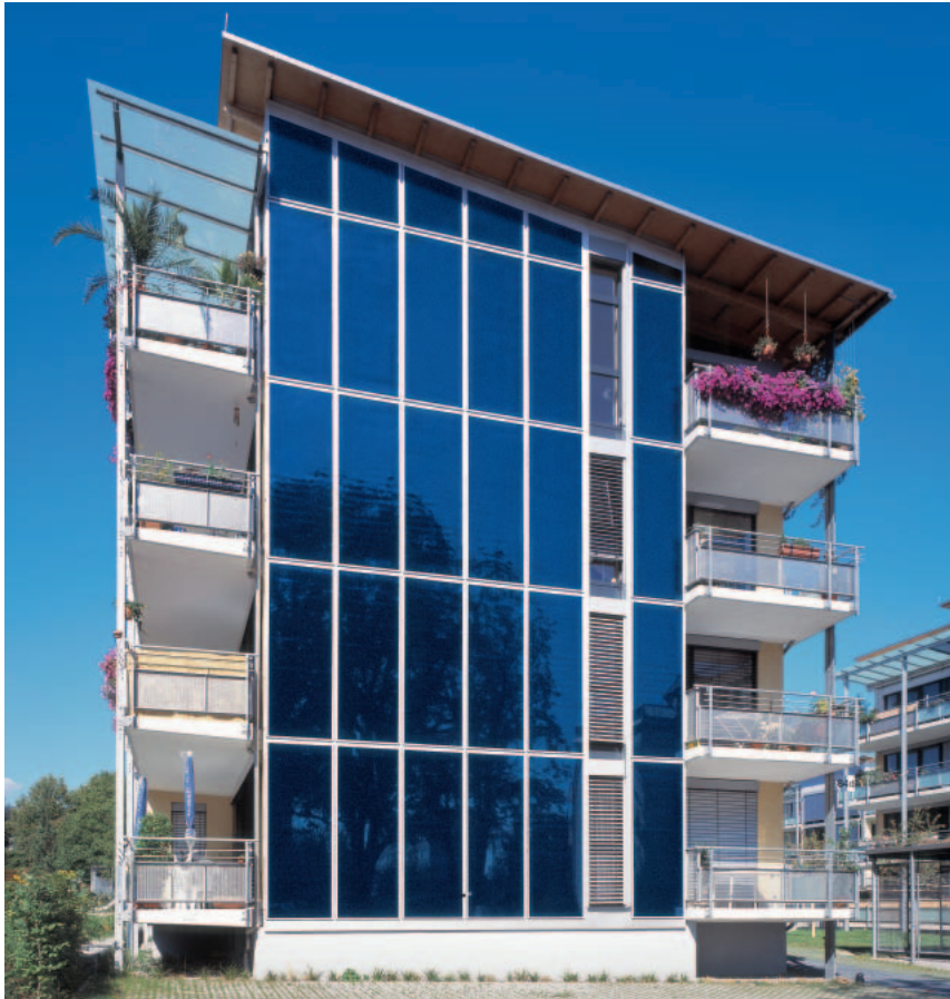
Mehrfamilienhaus mit Fassadenmontage
